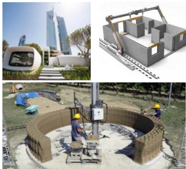
Рис. 9. 3D-принтер для строительства
